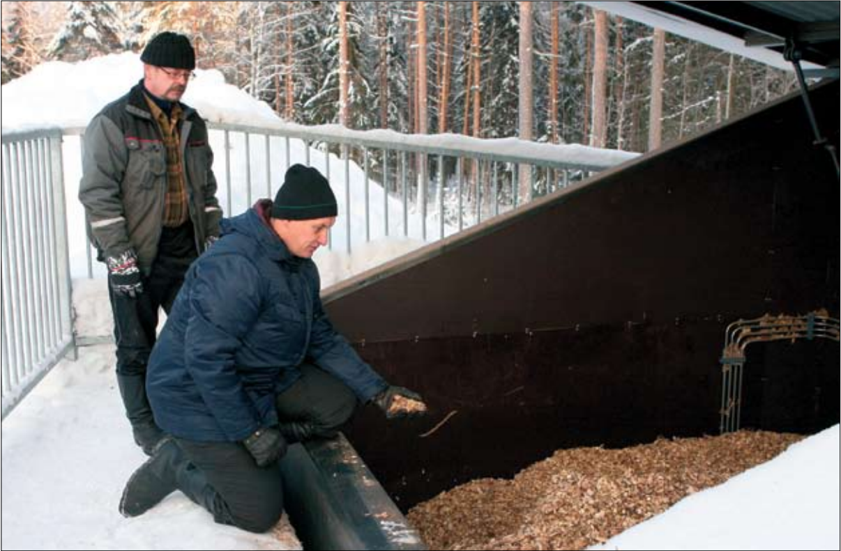
”Maatilakeskukseen sopiva tulitikkulaatikon kokoinen hake sopii hyvin myös tähän lämpölaitokseen. Kokopuu sopii tarkoitukseen parhaiten, sillä oksakohdat sumpuuntuvat laitteistossa helposti”, ylikiiminkiläiset Pentti Kääriä (takana) ja Markku Kirvesoja sanovat.
