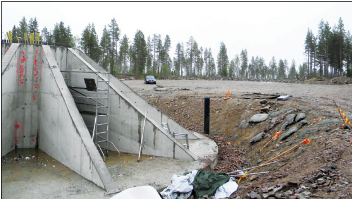
Tyypillisessä kolmesta neljään megawatin tuulivoimalan rakentamisessa on kyse teollisuuslaitoksen mittakaavaa olevasta investoinnista.
