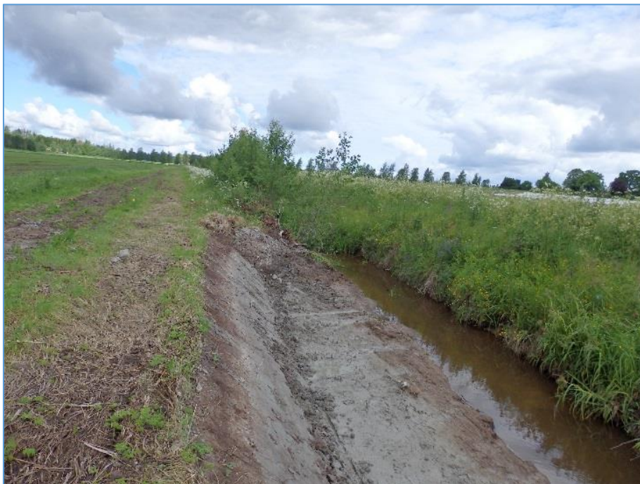
Kuva 10. Kaukanaronojalla tehdään luonnonmukaista peruskuivatusta. Työ viivästyi alkuperäisestä suunnitelmasta saada kaivu tehtyä keväällä 2017. Kuva: Kulmala
