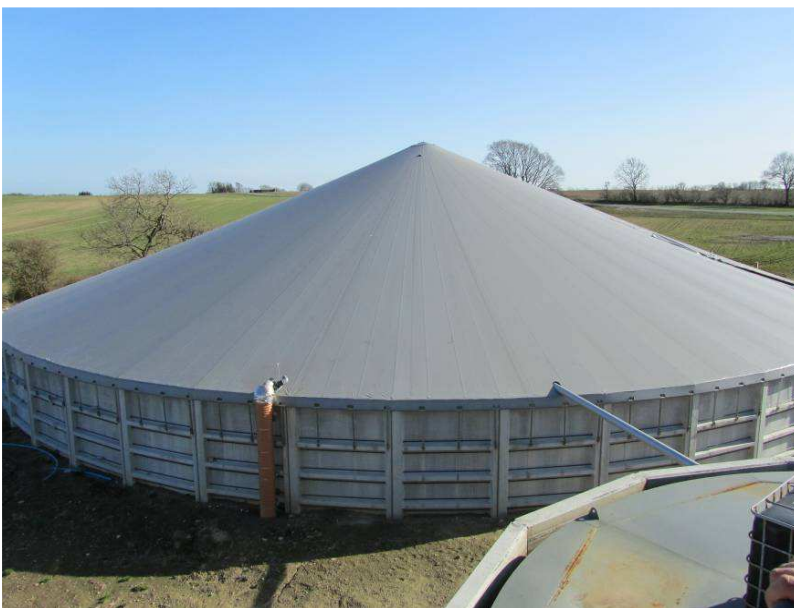
Kuva 3. Lietesäiliö biokaasulaitoksen vieressä. Säiliö on katettu, jotta ammoniakki ei haihtuisi lietteestä.
